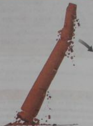
Figura 10.19 (Ejemplo conceptual 10.11) Una chimenea que cae se rompe en algún punto a lo largo de su altura.
