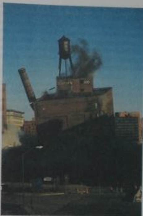
Figura P10.57 Demolición de un edificio en Baltimore, MD. A la izquierda está una chimenea, oculta principalmente por el edificio, que se ha roto en su caída. Compárela con la figura 10.19.
